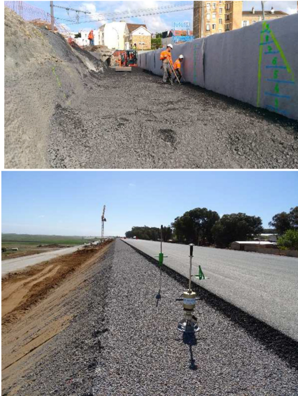
Contrôle de remblai par couche Essais de plateforme > 120 MPa avec poids de 20 kg
